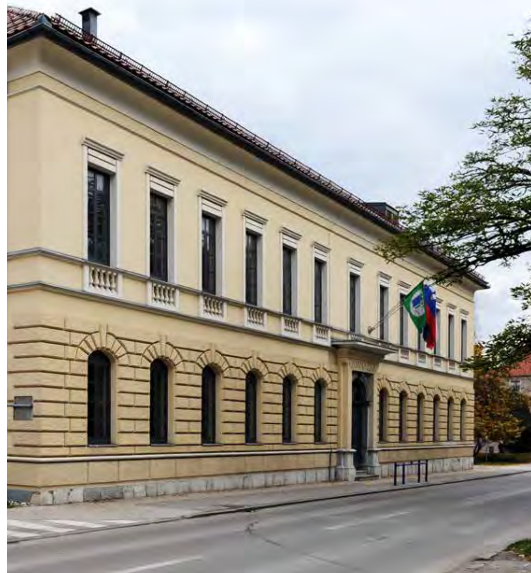
Gimnazijsko poslopje po obnovi, 2010, Gimnazija in srednja šola Kočevje, foto Bojan Štefanič
