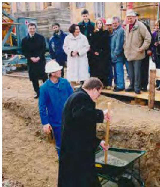
Položitev temeljnega kamna za obnovo stare gimnazijske stavbe in izgradnjo novega prizidka, 6. februar 2001, Gimnazija in srednja šola Kočevje
